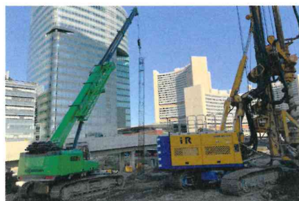
Mit einem Sennebogen 653 Teleskopkran werden die Bewehrungskörbe eingehoben.
