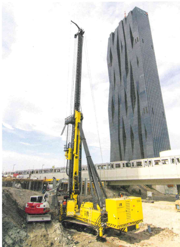
Österreichs erstes und derzeit einziges Großdrehbohrgerät der Type Fundex F3500 im Einsatz in der Wiener Donau City am Grundbau für den 110 m hohen DC3-Tower.
